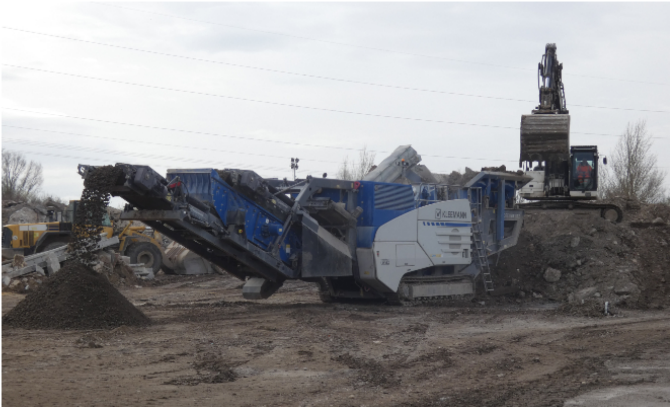
Les déchets de construction sont broyés au tractopelle puis déposés sur une sorte de table de tri avant d'être transformés.©YD
